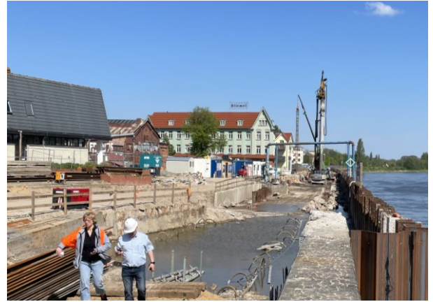
Herstellung/ Betrieb Grundwasserabsenkungsanlage aufgrund hohem Wasserandrang (06-11/2023)
