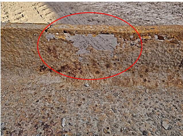
Ziehen der Altspundwand (05/2022): Schäden an der Altspundwand haben sich bestätigt
