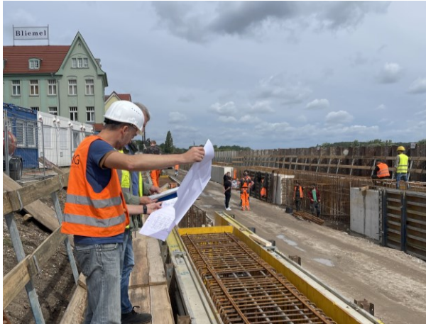
Herstellung Kopfbalken (07/2023-01/2024)
