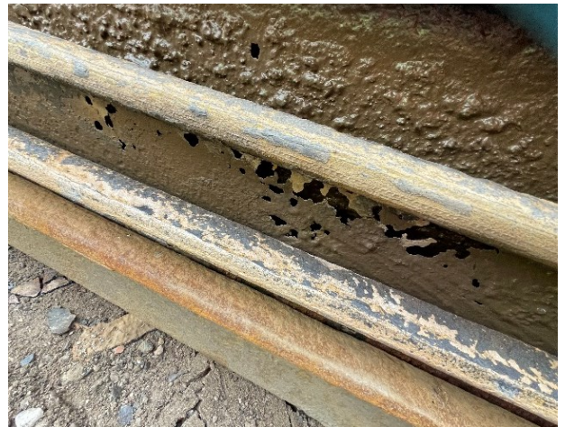
Ziehen der Altspundwand (05/2022): Schäden an der Altspundwand haben sich bestätigt
