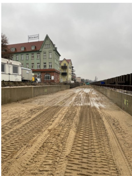
Verfüllung, Einbau Anker und Einbau Entwässerung/ Dränage (12/2023-02/2024)
