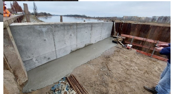
Links: Prüfung der Bohrpfähle in der hinteren Reihe 11-12/2024
