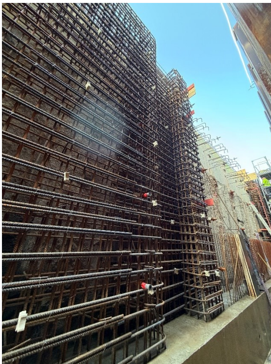
Ende 02/26 gehen die Arbeiten in der Baugrube weiter: es folgt die Betonage der ca. 6m hohen der Wandteile
