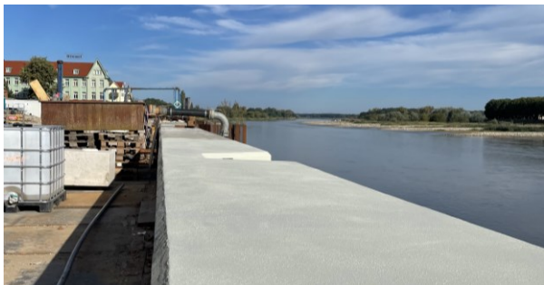
Betonsanierung Oberseite/ Wasserseite abgeschlossen / Einbau Hochwasserschutzfenster (09-11/2023)
