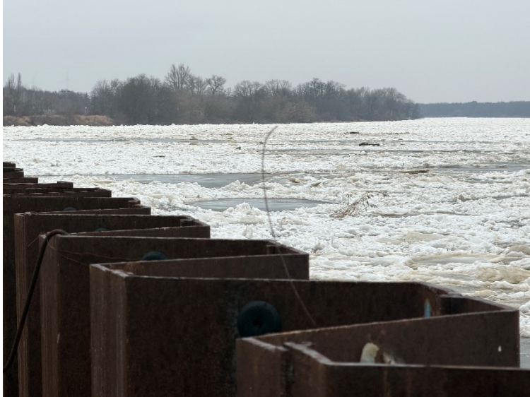
Oben: 02/2026 Eislage an der Oder: kurzzeitiger Wasserstandsanstieg bis nahe an die Alarmstufe I, die Baugrube wurde geflutet, als sicher war, dass die Eisgrenze Frankfurt (O.) erreichen würde
