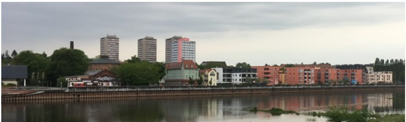
Abb. 2 Uferwand Frankfurt (Oder) – hier Abschnitt 1 Römertreppe bis Ziegelstraße 2021 vor Baubeginn
