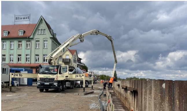
Herstellung 1.Abschnitt Unterwasserbeton 25.04.2024
