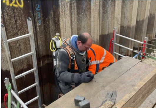
Vorbereitung Unterwasser- Betonage / erschütterungs- freier Rückbau Altspundwand: Tauchereinsatz (ab 03/2024)
