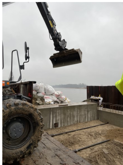
Verfüllung, Einbau Anker und Einbau Entwässerung/ Dränage (12/2023-02/2024)
