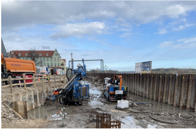
Herstellung/ Betrieb Grundwasserabsenkungsanlage aufgrund hohem Wasserandrang (06-11/2023)
