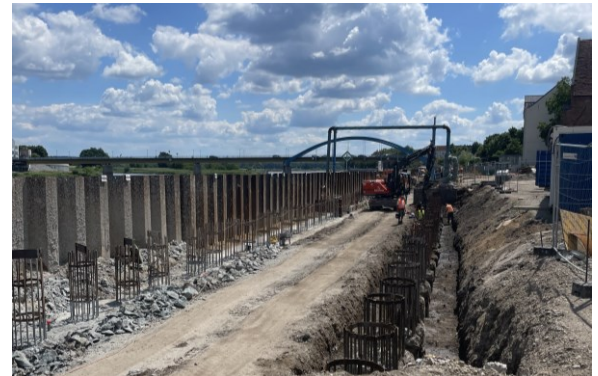
Herstellung/ Betrieb Grundwasserabsenkungsanlage aufgrund hohem Wasserandrang (06-11/2023)
