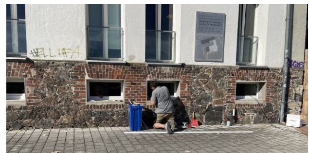
Betonsanierung Oberseite/ Wasserseite abgeschlossen / Einbau Hochwasserschutzfenster (09-11/2023)
