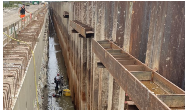
Auspumpen/ Reinigen Bohrpfähle (ab 05/2024)
