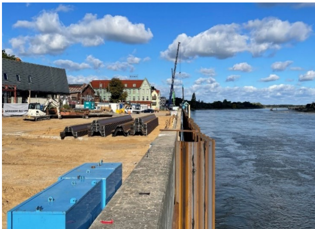
Einpressen der Baugrubenspundwand (09-11/2022)
