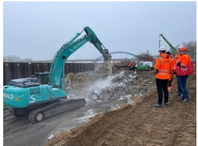
Abbrucharbeiten im Bereich Römertreppe (11/2022)
