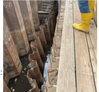
Vorbereitung Unterwasser- Betonage / erschütterungs- freier Rückbau Altspundwand: Tauchereinsatz (ab 03/2024)
